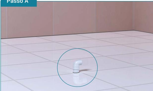
Durante a obra, instalar o ponto de esgoto no piso e prever um joelho de 90° (esgoto Ø40 mm ou Ø50 mm).
